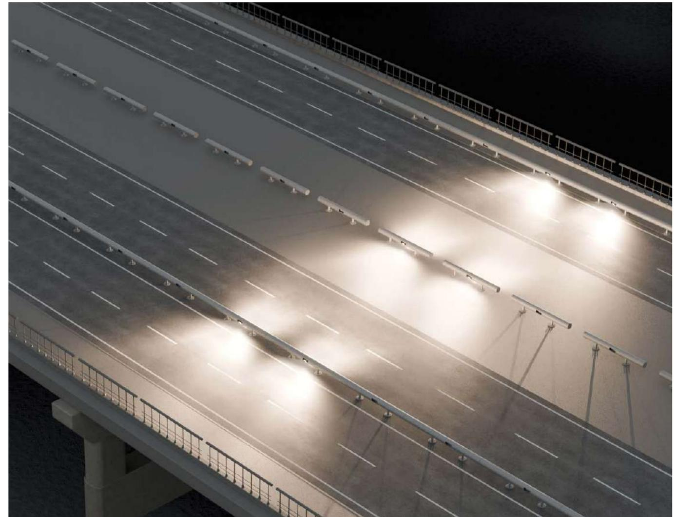
Éclairage routier à des hauteurs de montage très basses, par exemple ponts
